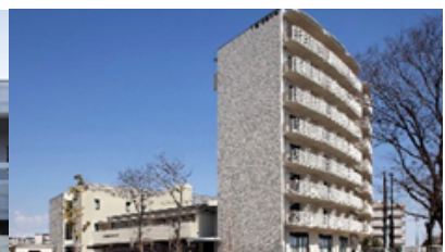
南千里国際プラザ留学生寮
