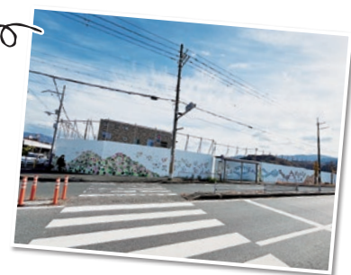
みんなで仮囲いに貼り込み作業を行なった。
